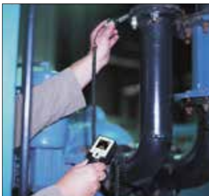
Slika 4. Odkrivanje puščanja z ultrazvočnim detektorjem na prirobnem spoju
