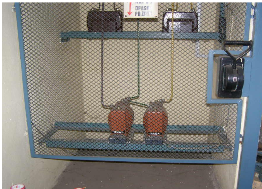
Slika 3. Zajednički smještaj SMT i NMT u starijim zidanim TS
