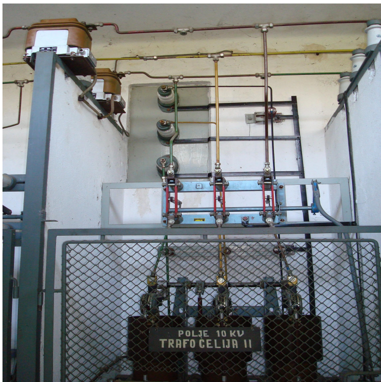
Slika 4. SMT u sabirničkom dijelu zidane TS
