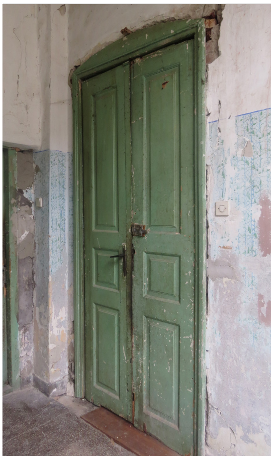
Vrata polukružnog stubišta na katu
