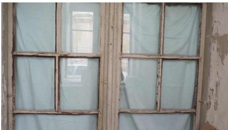
Prozor sa profiliranim fiksnim prečkama – prizemlje istočnog dvorišnog krila, kuhinja
