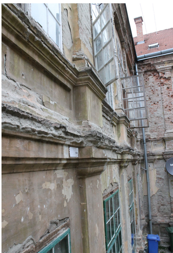
Razdjelni vijenac i parapetna zona kata, dvorište
