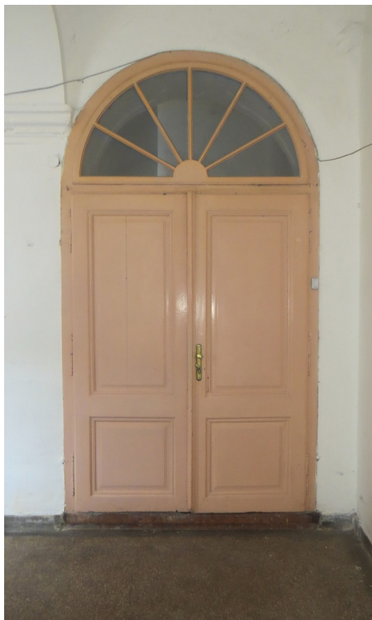
Vrata stubišta, zapadno krilo - prizemlje
