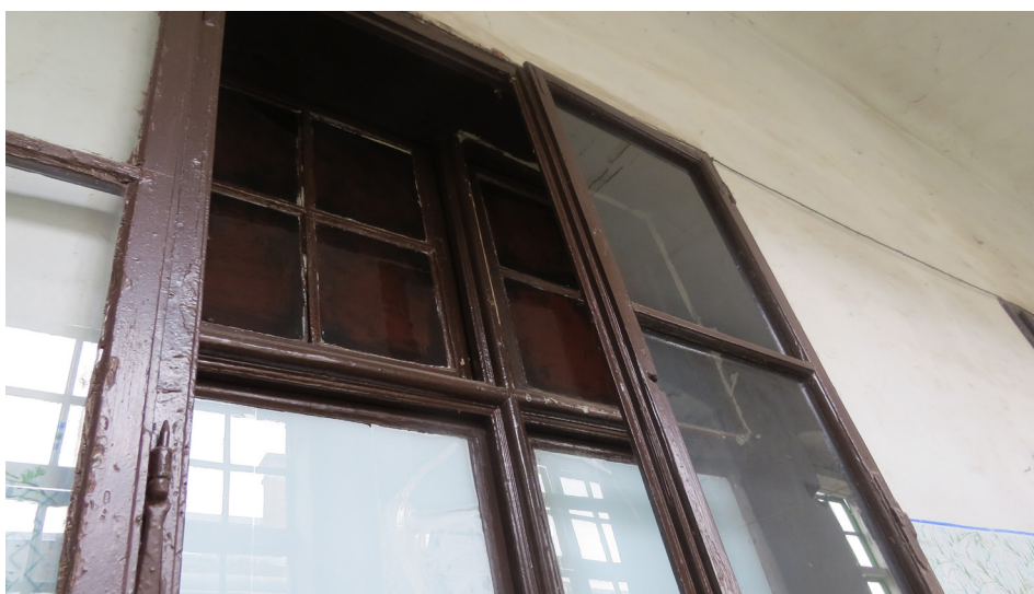
Prozor sa profiliranim fiksnim prečkama – kat istočnog dvorišnog krila, soba 22
