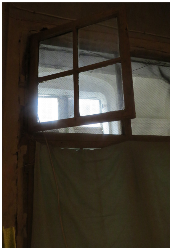
Prozor kuhinje – pogled iznutra
