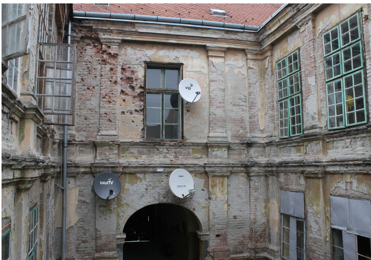
Dvorišno pročelje uličnog krila
