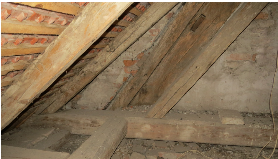
Ostatci prvotne krovne konstrukcije u istočnom zabatu
