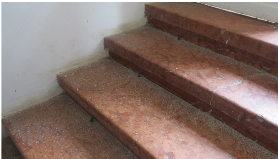
Glavno stubište - detalj stuba
