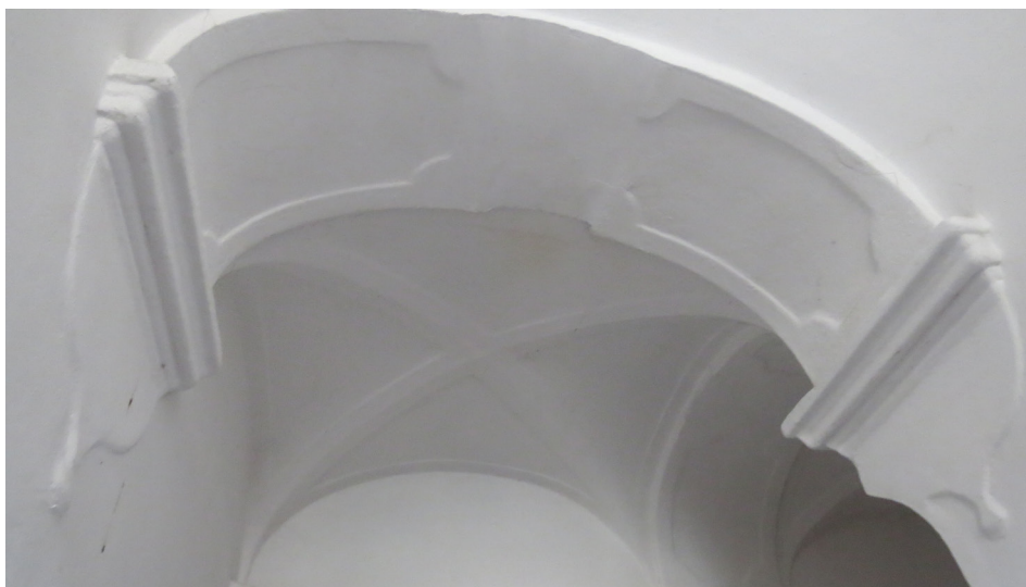
Glavno stubište - pogled na svod
