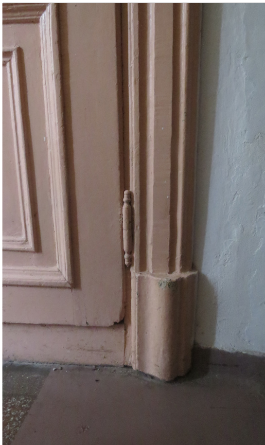
Detalj vrata tavanaskog stubišta
