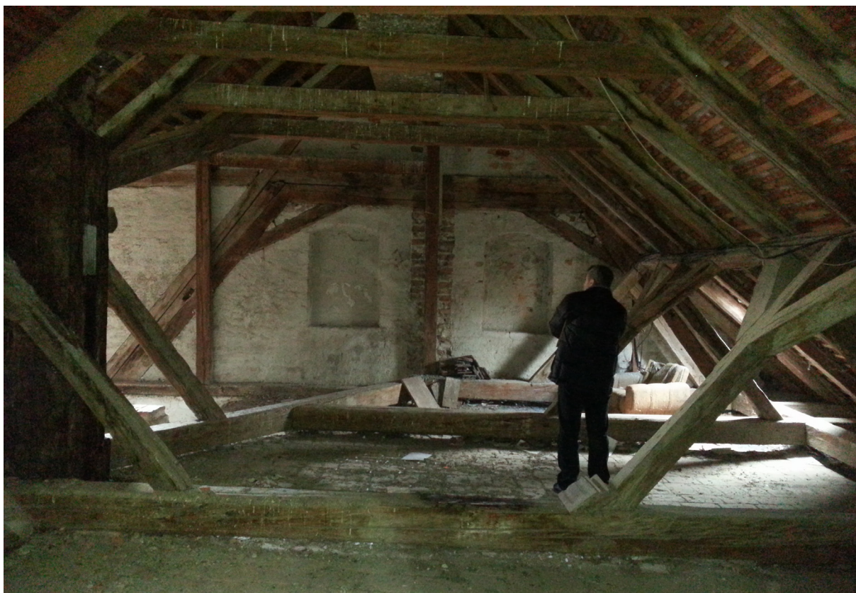
Krovište uličnog krila, pogled na zapadni zabat s ostacima prvotne krovne konstrukcije
