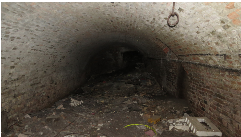
Svod podruma istočnog dvorišnog krila
