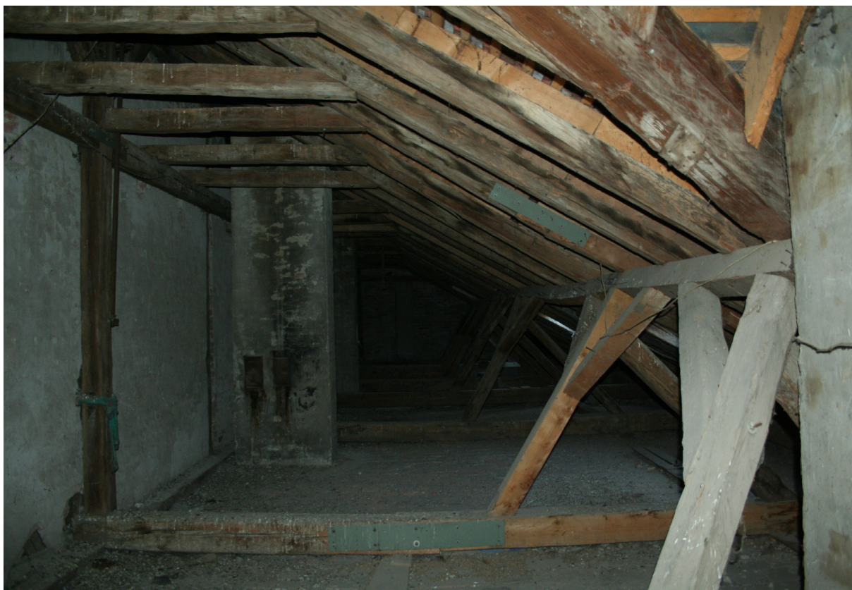
Krovište istočnog dvorišnog krila
