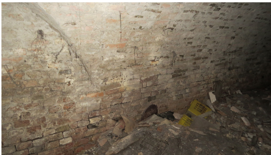
Podrum - spoj uličnog i istočnog krila, istočna strana
