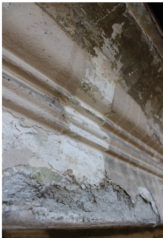
Krovni vijenac uličnog pročelja
