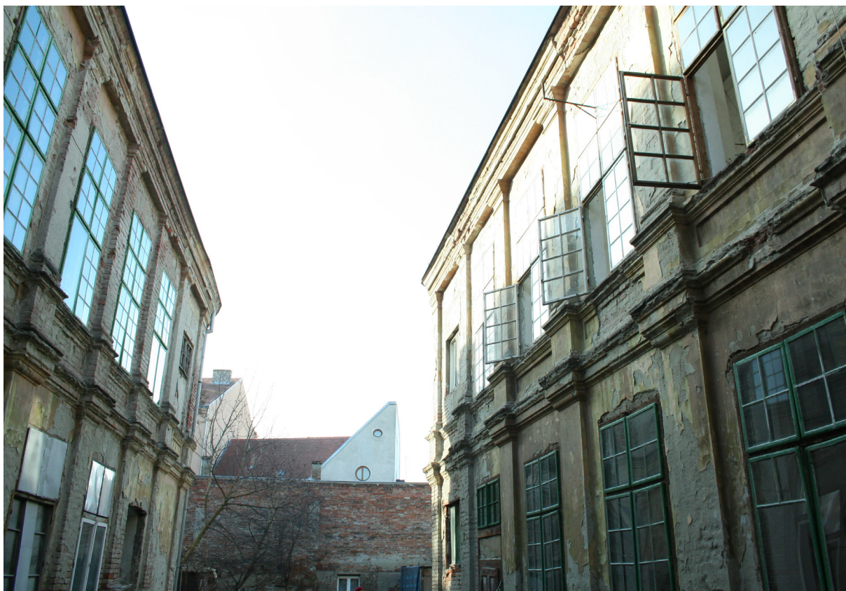
Pogled na dvorišna krila iz ulazne veže
