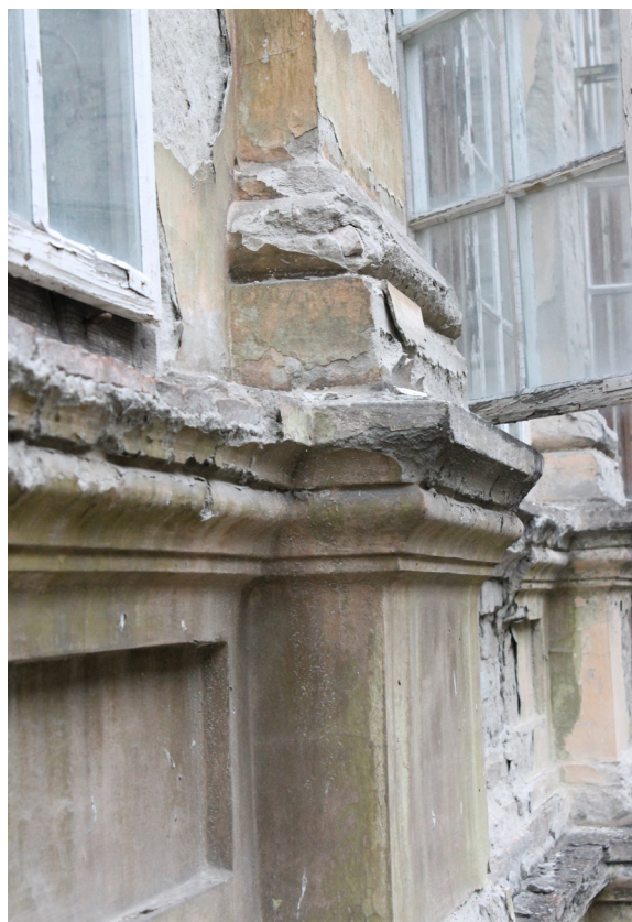
Postament pilastra – kat dvorišnog pročelja
