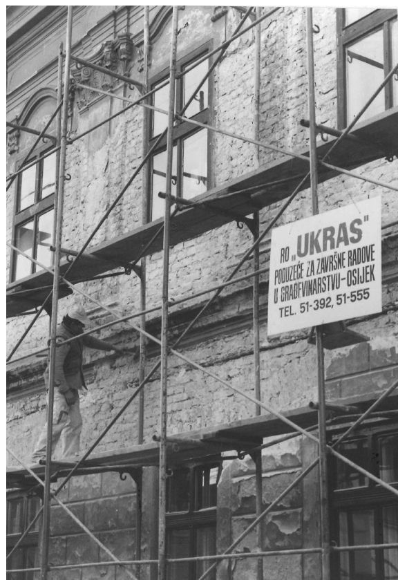
Uklanjanje žbuke sa glavnog pročelja, krajem 60-ih godina 20.st.
