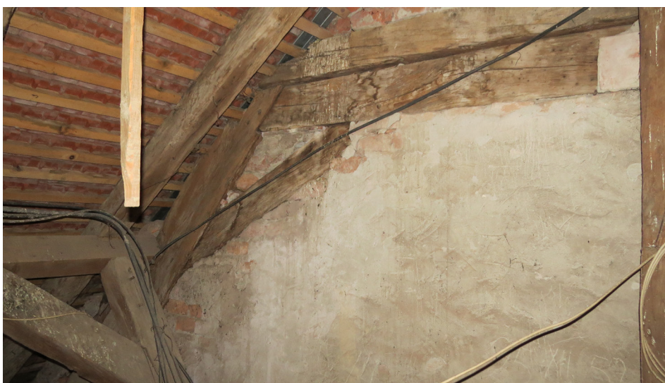
Ostatci prvotne krovne konstrukcije u istočnom zabatu
