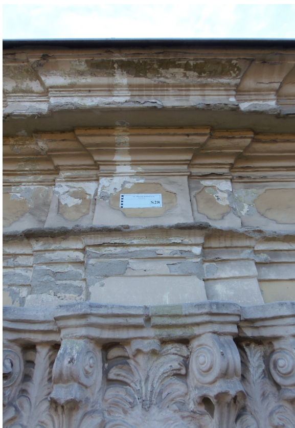
Detalj završne trabeacije uličnog pročelja
