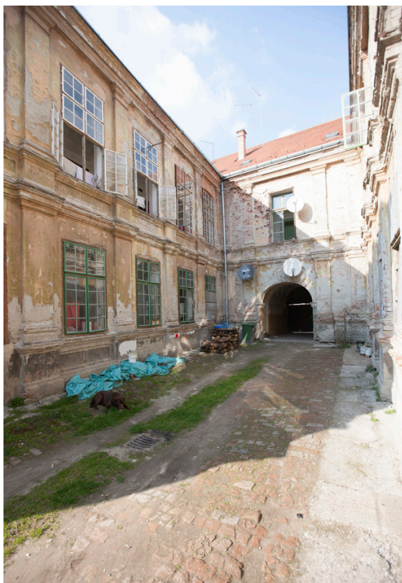
Pogled na zapadno dvorišno krilo
