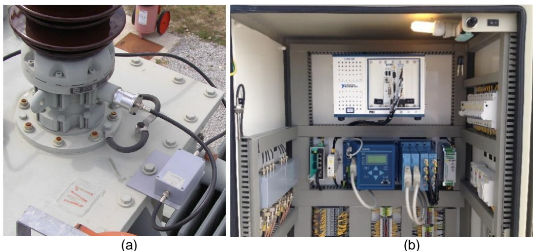
Slika 1. (a) Mjerni priključak provodnog izolatora; (b) sustav Končar TMS+ za snimanje prenapona na kompenzacijskoj prigušnici snage 100 MVar u 110 kV postrojenju TS Ernestinovo.
