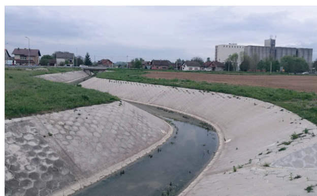
Slika 2: Primjeri korištenja šesterokutne prizme u praksi – za oblaganje otvorenih kanala
