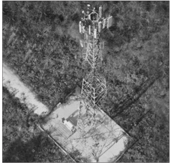
Slika 8. 3D Reality Mesh telekomunikacijskog tornja
