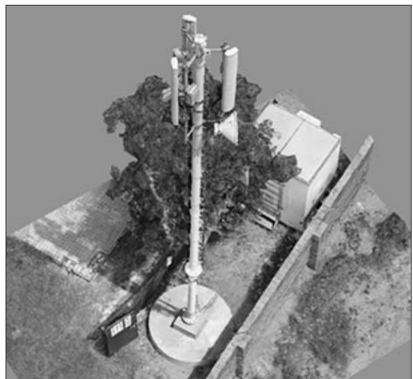
Slika 9. Testni primjer telekomunikacijskog stupa
