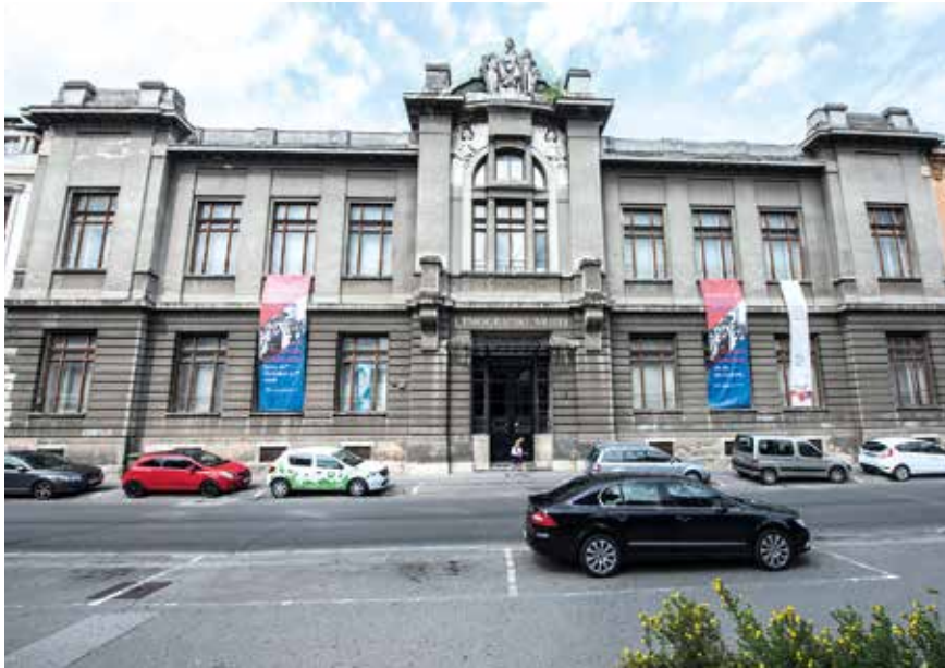
Glavno, ulično pročelje Etnografskoga muzeja prije početka radova 2016. (Hrvatski restauratorski zavod)
