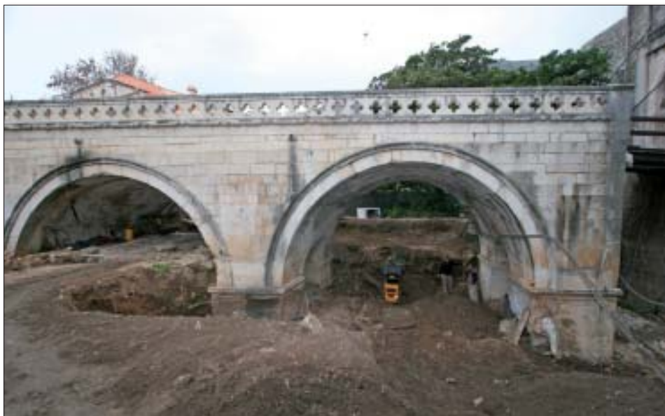
Slika 8. Pogled na most (J-S), 2014.
