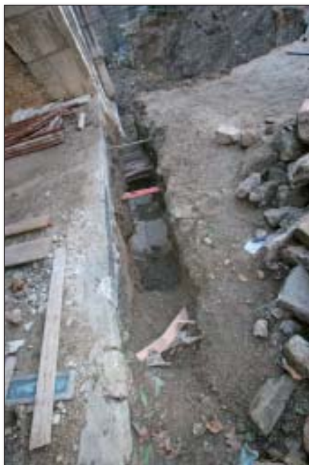
Slika 16. Kontrolni kanal s južne strane zapadnog luka
