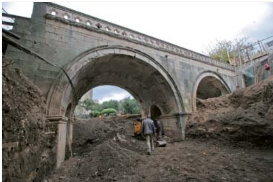
Slika 14. Pogled na most odozdo
