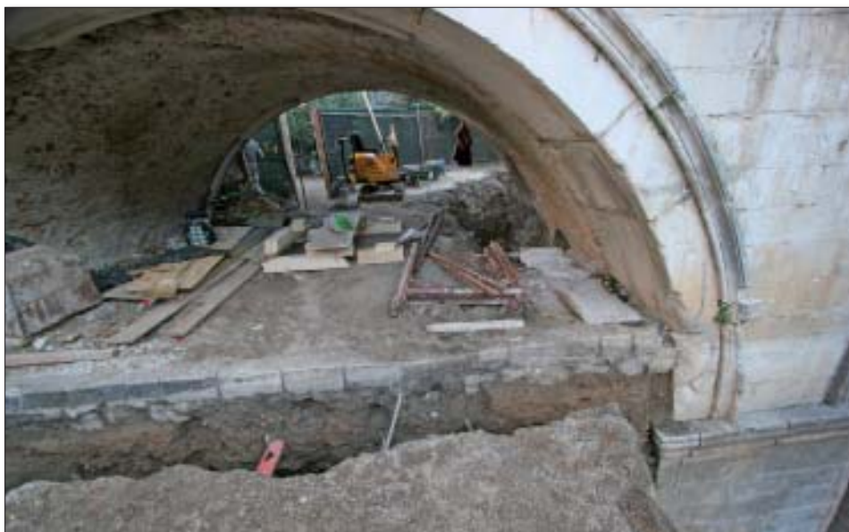
Slika 17. Nasip pod zapadnim lukom mosta
