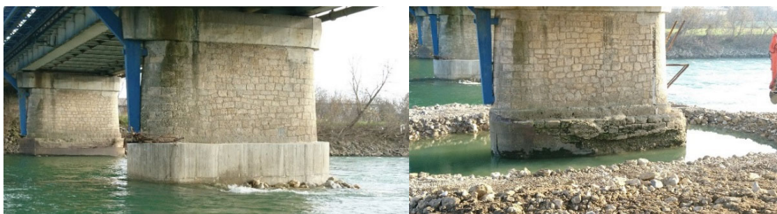
Slika 8. Pogled s desne obale na stupove mosta Podsused: a) prethodno sanirani srednji stup (lijevo); b) desni stup tijekom sanacije (desno)
