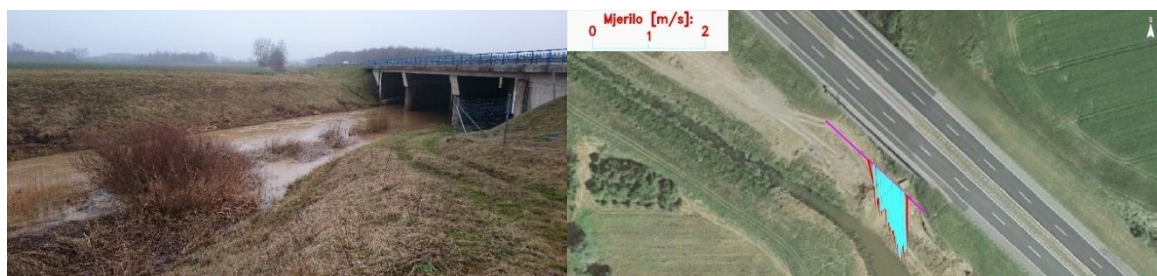
Slika 4. Lateralni kanal: a) suženje protočnog profila uzvodno od mosta, pogled s desne obale (lijevo); b) prevaljeni profil brzine toka na ortofoto podlozi (desno)
