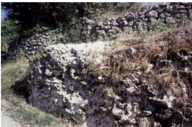
Abb. 4. Die westliche Wehrmauer.
